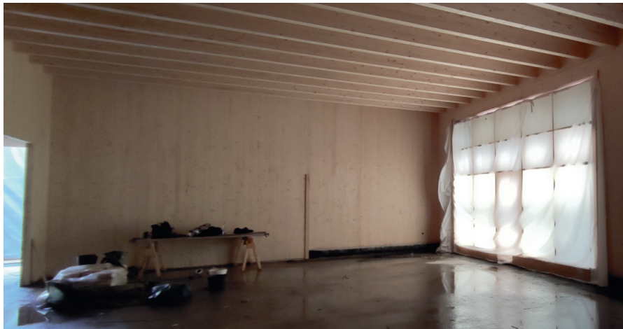
Der vordere Teil des Bewegungsraums, bei Teilung Raum 1
